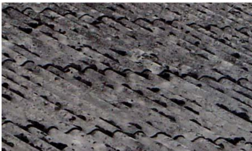
Rys. 4 Pokrycie dachowe z płyt azbestowo-cementowych
