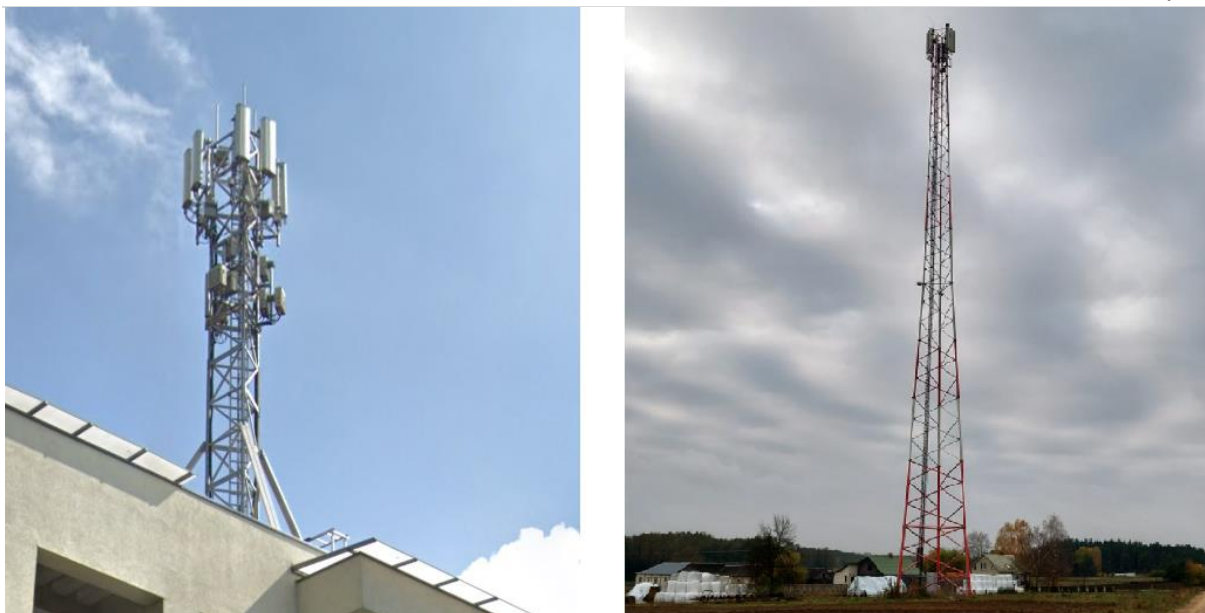
Rysunek 9. Stacje bazowe telefonii komórkowej na dachu budynku oraz wolnostojąca
