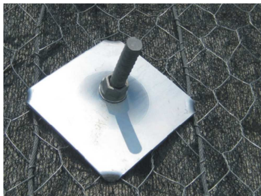
Przykładowe fotografie siatki i jej mocowania na skarpie
