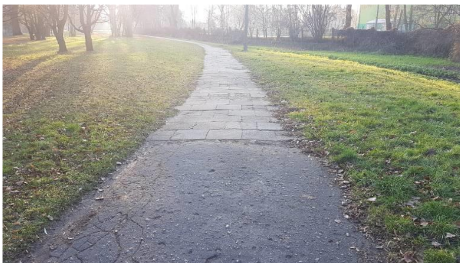
Ryc. 1 Łączenie nawierzchni asfaltowej z płytami betonowymi w północnej części opracowania
