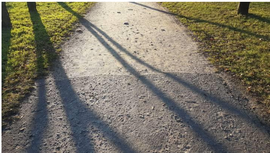
Ryc. 2 Łączenie nawierzchni asfaltowej z nawierzchnią ziemno-żwirową
