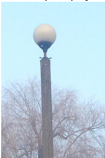
Ryc. 12 Kulista, mleczna oprawa oświetleniowa (źródło: materiały własne)
