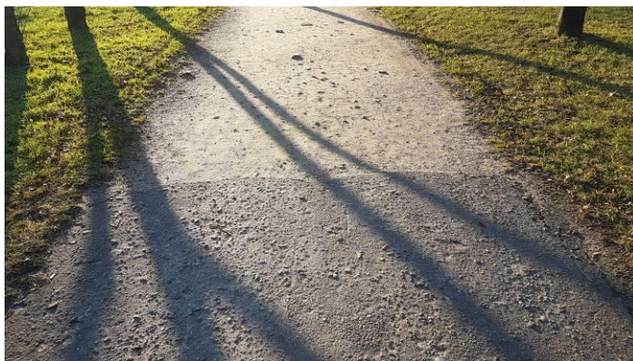
Ryc. 9 Łączenie nawierzchni asfaltowej z nawierzchnią ziemno-żwirową (źródło: materiały własne)
